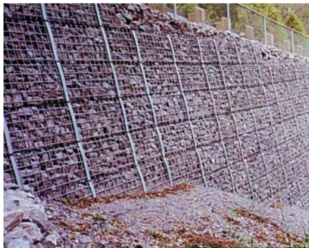
Mynd 27: Veggur úr stálgrindum með grjóthleðslu.
