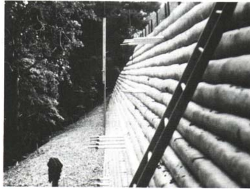
Mynd 10: Nokkuð hár veggur myndaður með því að bretta dúkinn til baka inn í vegginn.
