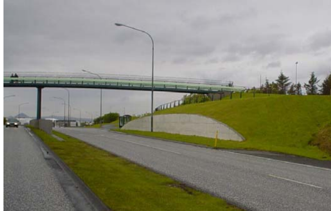
Mynd 16: Göngubrú í Garðabæ. Nostast er við steiptan stoðvegg og mikið pláss fer í fláa.
