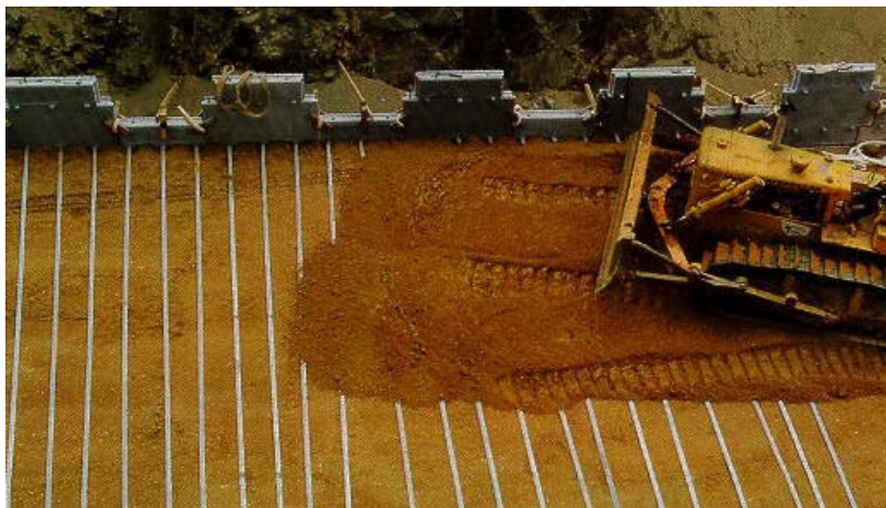
Mynd 6: Veggur með ræmum í byggingu.
