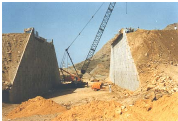
Mynd 15: Brúarstólpar úr styrktum jarðvegi.
