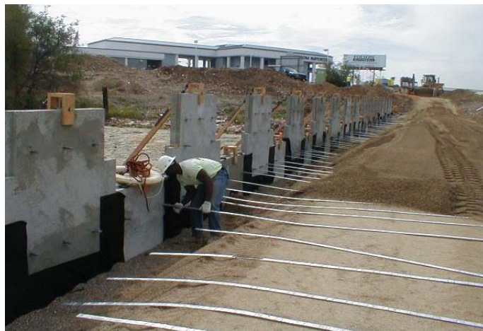
Mynd 7: Veggur reistur úr steiptum einingum og styrktur með stálræmum.
